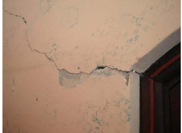
Crack above the door
